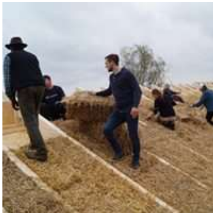
Abbildung 15: nabus auf der Baustelle - Einbau einer Dachdämmung aus Stroh
