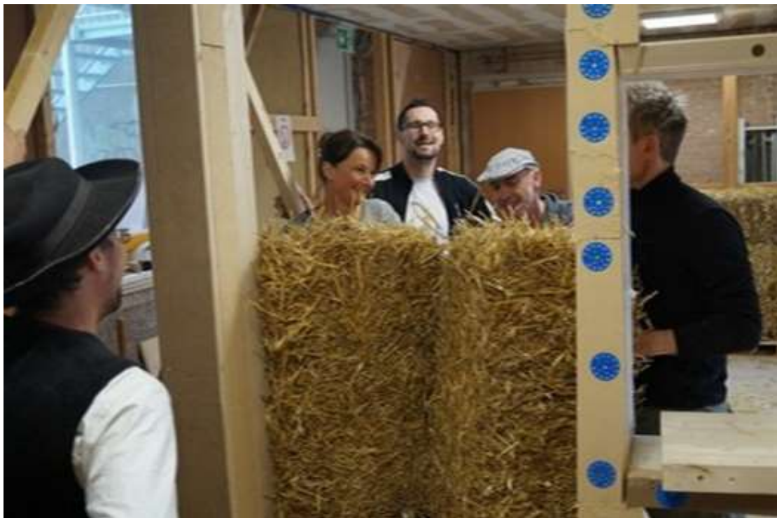
Abbildung 18: Der Stroheinbau wurde in einem Holzbaurahmen stehend und liegend umgesetzt, um an das Bauen neuer Gebäude wie auch an das Sanieren bestehender Häuser anzuknüpfen
